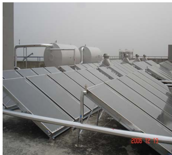
圖 6 宿舍太陽能系統設備
